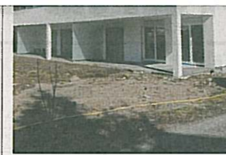
Die Bauarbeiten gehen zügig voran. FOTO: THE
